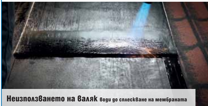
Прегряване на материала
