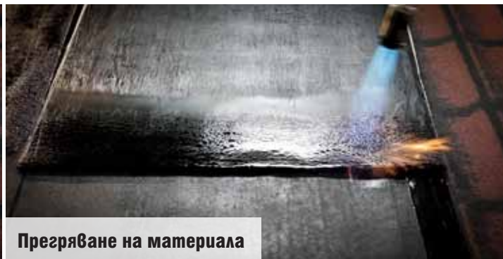
Неизползването на валеж води до сплескване на мембраната
