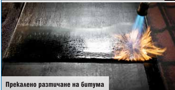
Неизползването на валеж води до сплескване на мембраната
